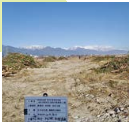
上：県発注の河川内にある支障木伐採 右：砂防堰堤工事の際の支障木伐採
