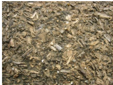
施工後3年8か月経過した舗装表面の様子
